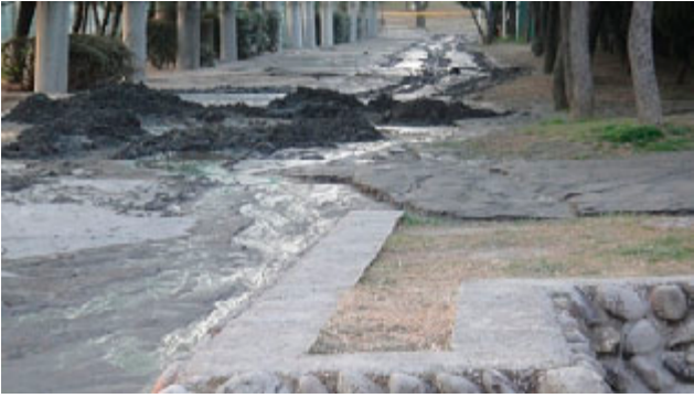
写真2.4-1 液状化による噴砂(千葉県浦安市)
