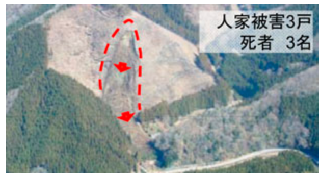
写真3.3-35 福島県いわき市田人町の土砂崩れの様子 1)
