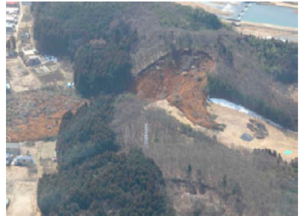
写真3.3-34 福島県 白河市の地滑りの様子 4)
