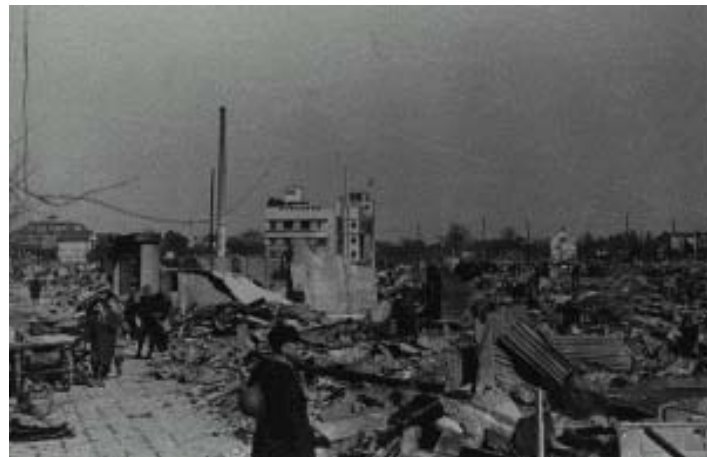
焼け落ちた九段南近辺(昭和20年3月)昭和館石川光陽写真展HPより
