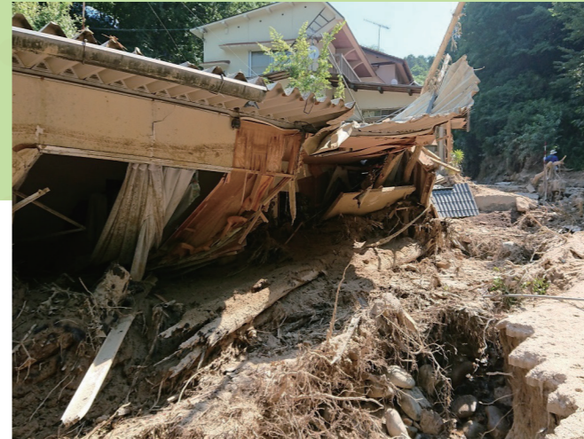
平成 30 年 7 月西日本豪雨での被災写真
