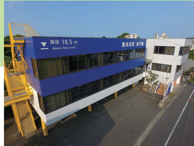
屋上へ避難できる外部階段を設置し、標高を明記した自社ビル
