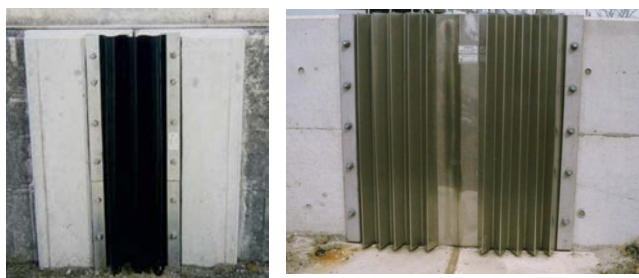
ゴム製可撓性材の設置例 ステンレス製可撓性材の設置例
