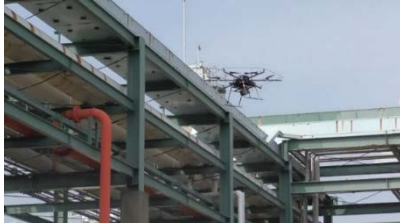
ドローンによる点検の様子
