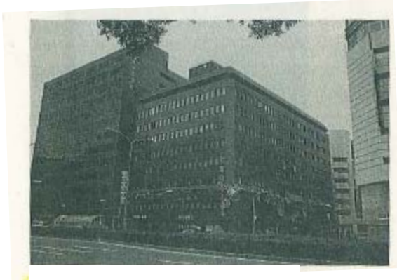
写真3 10層建物：3層崩壊
