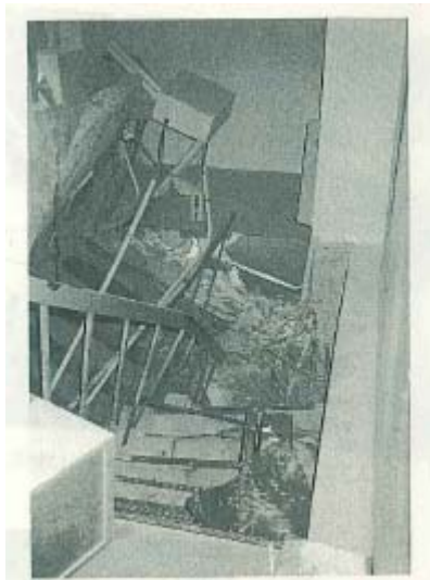
写真7 階段1, 2階部分の破損状況
