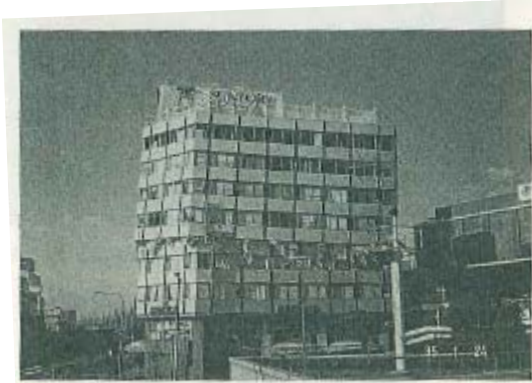
写真1 9層建物：5層崩壊
