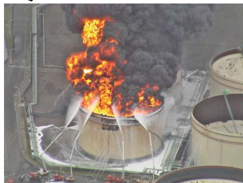
浮き室損傷のため浮き屋根沈下 タンク全面火災発生
