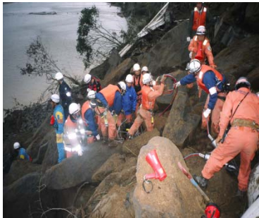
新潟県中越地震(長岡市妙見堰)
