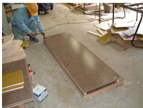
図 2.2.3.1 エコボードのせき板ユニット加工
