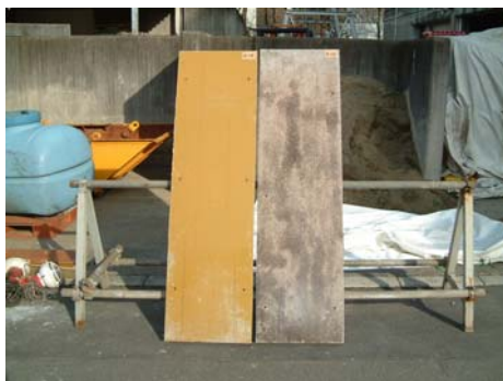
図 2.2.3.7 脱型後の柱せき板 (左：オーバーレイ合板、右：エコボード)
