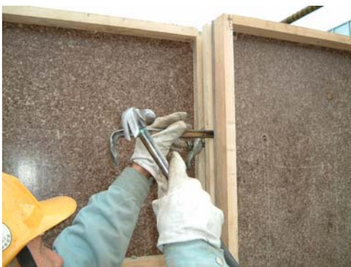
図 2.2.3.3 脱型作業の様子
