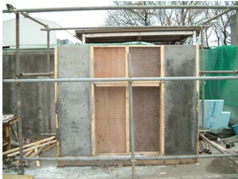
図 2.2.3.5 脱型直後の柱表面 (左：オーバーレイ合板、右：エコボード)
