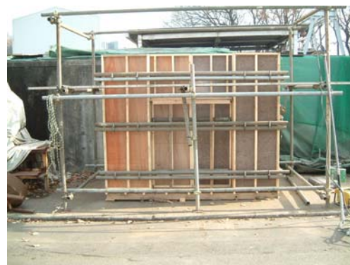
図 2.2.3.2 実大試験体型枠組み立て完了状況
