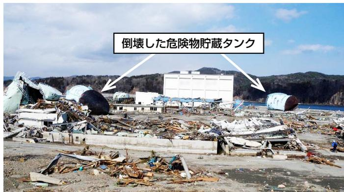
津波により倒壊した危険物貯蔵タンク
