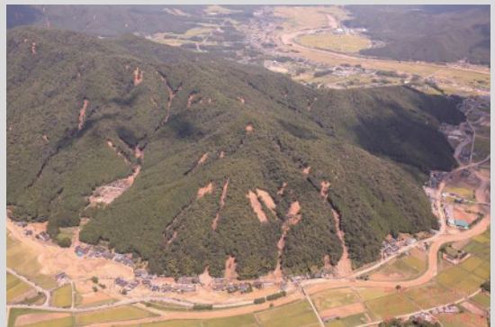
土砂災害発生現場
