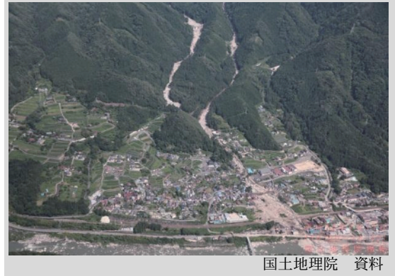
土石流発生現場
