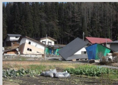
倒壊した家屋
