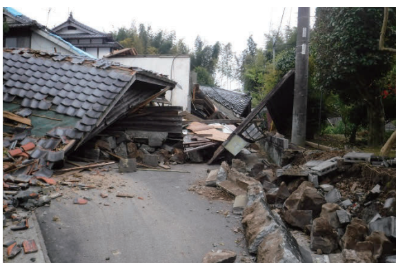
倒壊した木造家屋
