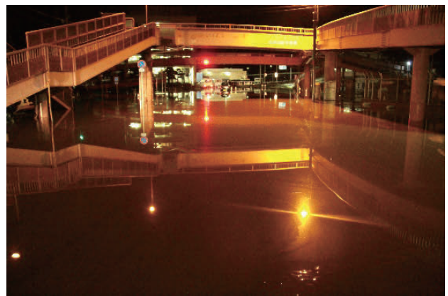
街中の浸水の様子
