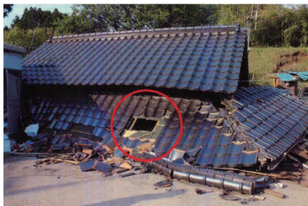
チェーンソーで倒壊家屋の屋根に穴をあけて救出
