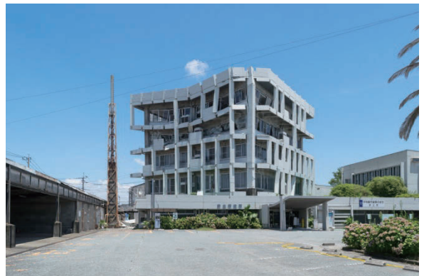
4階、5階部分が倒壊した宇土市本庁舎
