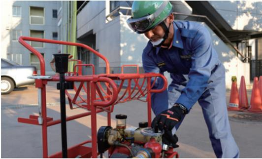
16 水がきてから管その先端を開放した方が安全に放水を開始できます。放水を始めたら水圧による反動力でバランスを崩さないよう放水が終わるまで、しっかりと保持します。前傾姿勢を取り、反動力を抑えます。
