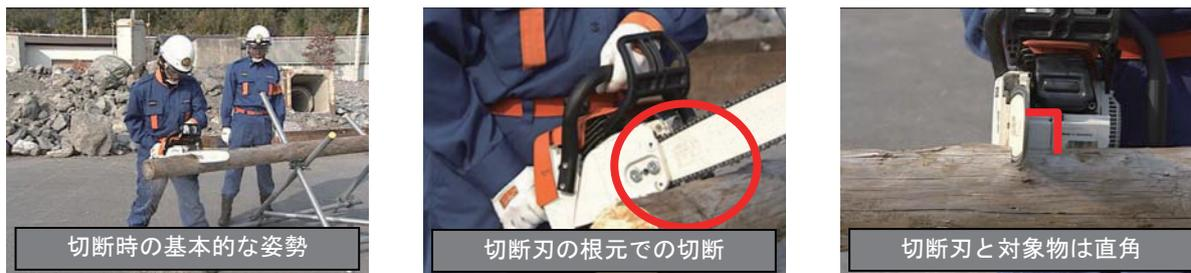
図 4.4 チェーンソーによる切断
