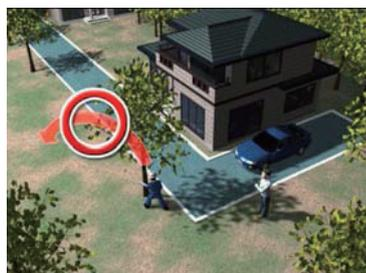
図 4.8 倒れる方向の選定
