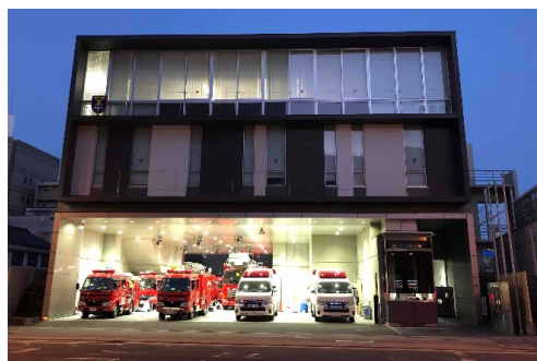
大阪市消防局 東成消防署
