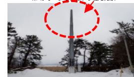
<風車の羽根の脱落>
