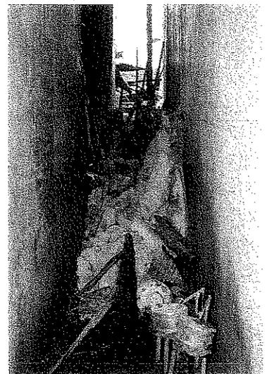
図3 消防活動時の放水により崩落した土蔵の土(1996年火災) 土蔵間の路地部分に土が1.7mの高さまで堆積している。
