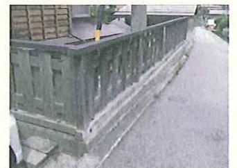
コンクリート壁による家屋内部への雨水防止
