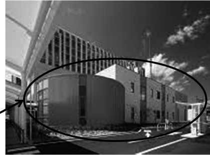
仙台市救急ステーション
