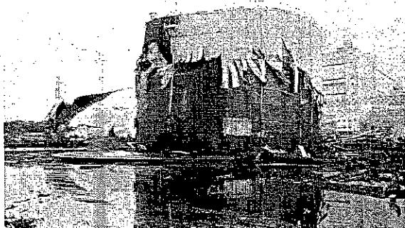
原町火力発電所重油タンク被災状況
