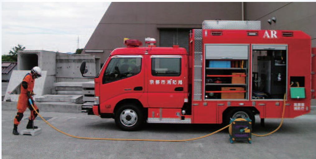
写真5 エアマンを使用したコンクリートの破壊
