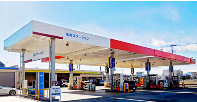
Hydrogen station built in a gas station ガソリンスタンドに併設して設置された水素ステーション
