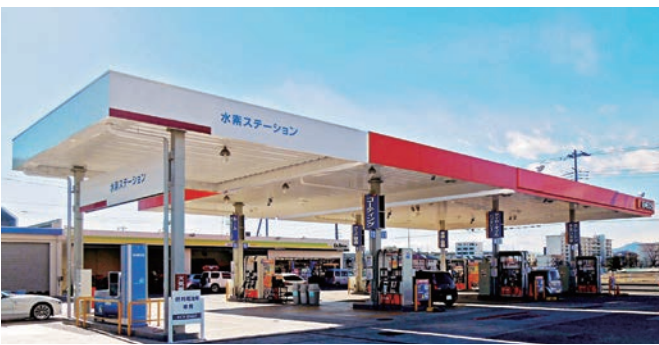
ガソリンスタンドに併設して設置された水素ステーション
