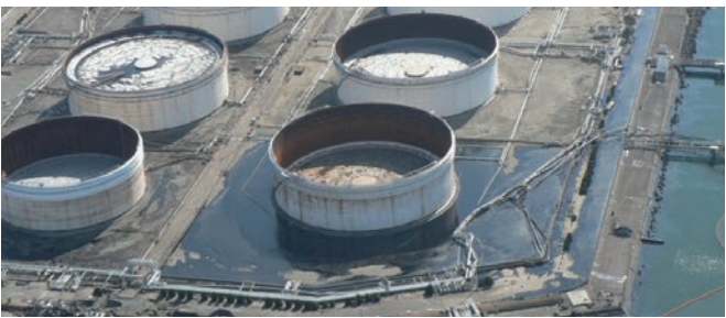
屋外タンク貯蔵所からの危険物が流出/東日本大震災（仙台市消防局提供）
