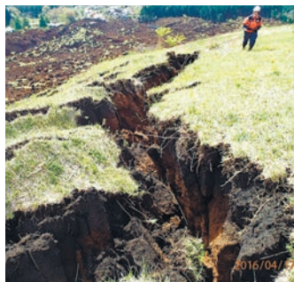
平成28年熊本地震により引き起こされた土砂災害現場において、救助活動現場での二次災害の危険性を評価するため、崩れた崖の周辺の地形と地質を調査を実施
