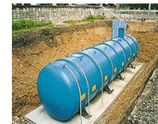
【耐震性貯水槽】
