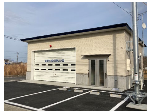
【消防団拠点施設復旧事業】 福島県双葉郡富岡町 夜の森消防屯所（第3分団）
