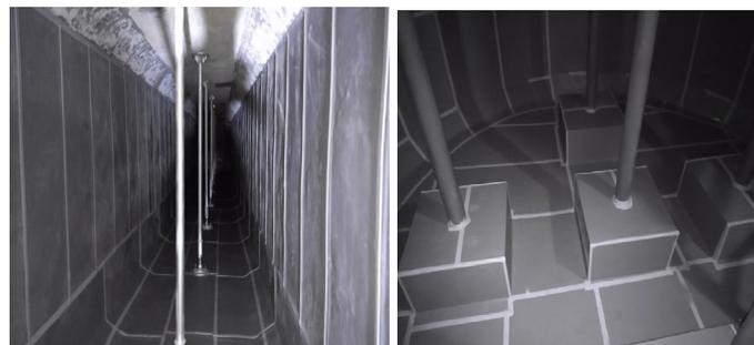
【防火水槽内部写真】支柱等を設置し、水槽強度の強化（長寿命化）
