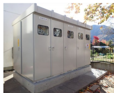
電源設備嵩上げ
