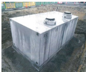
耐震性貯水槽
