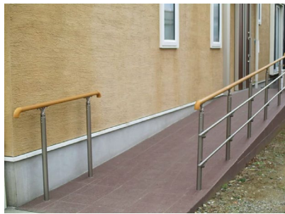
スロープの設置
