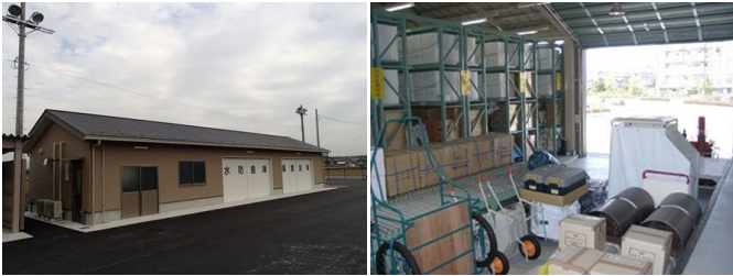
防災資機材等備蓄倉庫
