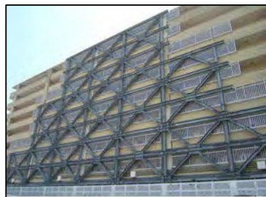
耐震補強工事
