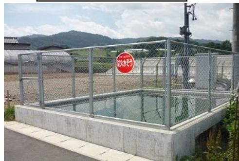
防火水槽等の更新
