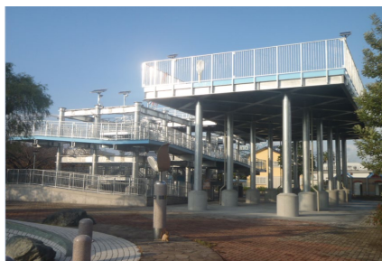
津波避難タワー
