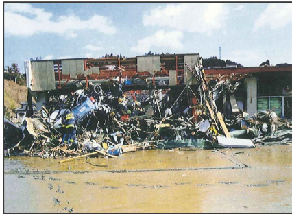
被災状況（津波浸水）
