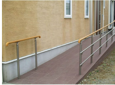
スロープの設置
