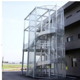
避難階段の設置
