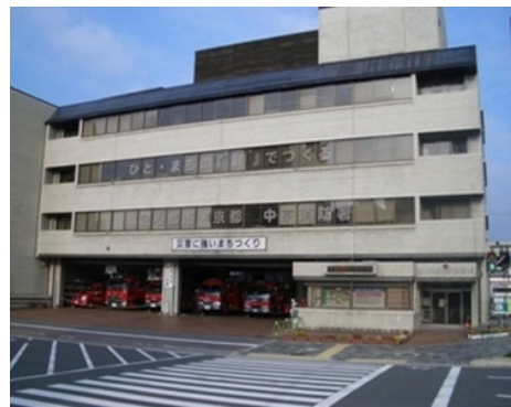
消防署 (京都市消防局)
