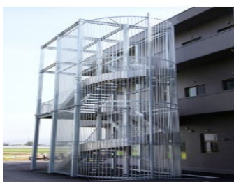
避難階段の設置
