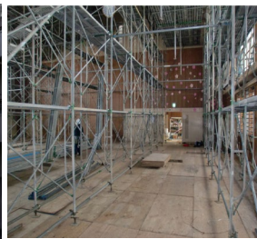
安全性向上のための改修
