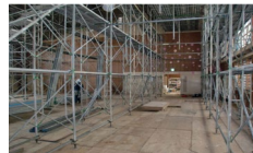
安全性向上のための改修
