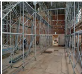
安全性向上のための改修
