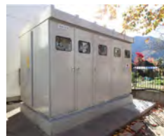
電源設備嵩上げ
