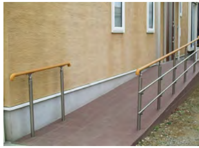
スロープの設置
