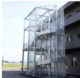
避難階段の設置
