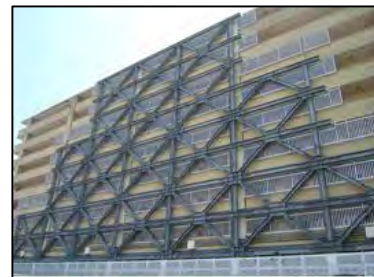
耐震補強工事
