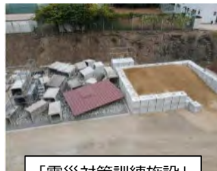
「震災対策訓練施設」
