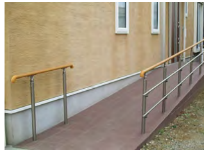
スロープの設置
