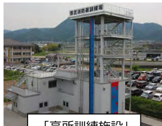
「高所訓練施設」
