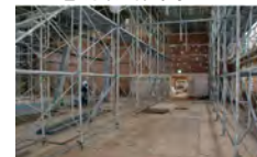
安全性向上のための改修
