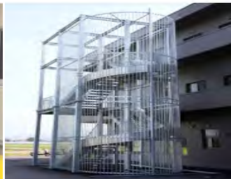
避難階段の設置
