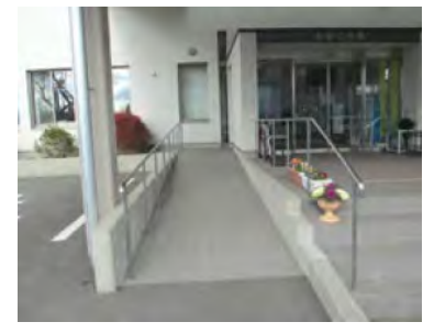
出入口の段差解消
