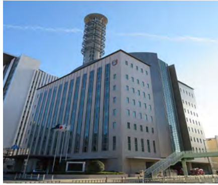
消防本部(消防署併設) (大阪市消防局)
