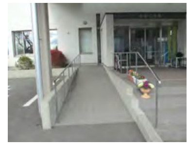
出入口の段差解消
