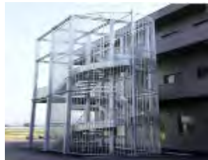
避難階段の設置
