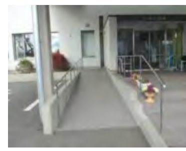
出入口の段差解消
