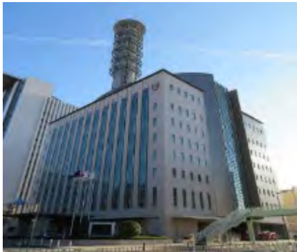
消防本部(消防署併設) (大阪市消防局)
