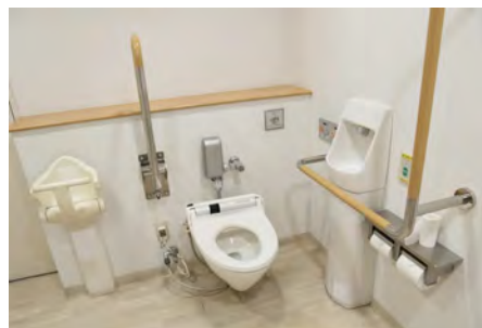
多機能トイレの整備
