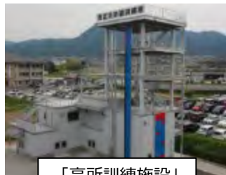
「高所訓練施設」
