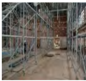
安全性向上のための改修
