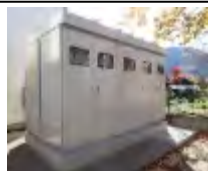
電源設備嵩上げ
