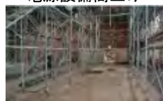
安全性向上のための改修
