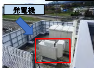
浸水に対する対策例 ＜屋上に非常用電源を設置＞
