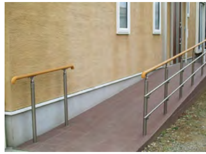
スロープの整備
