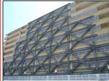
耐震補強工事
