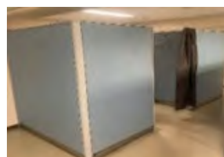
更衣室の整備
