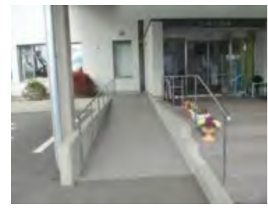
出入口の段差解消
