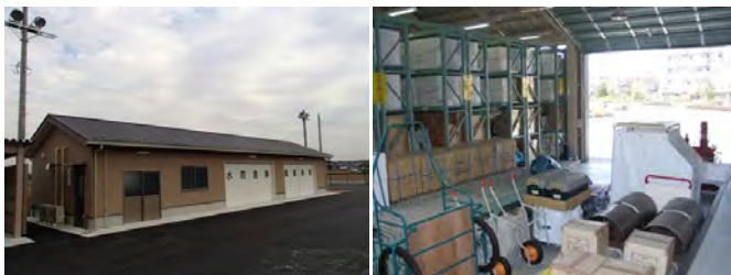
防災資機材等備蓄倉庫
