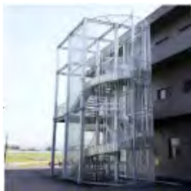
避難階段の設置
