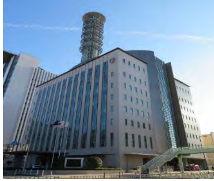
消防本部(消防署併設) (大阪市消防局)
