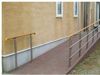
スロープの整備
