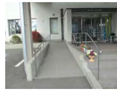
出入口の段差解消
