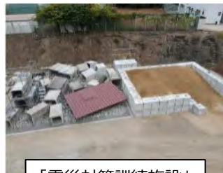
「震災対策訓練施設」
