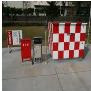
自家給油施設
