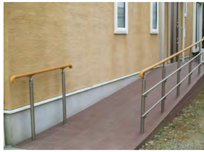
スロープの整備
