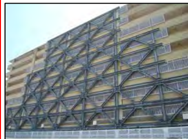
耐震補強工事
