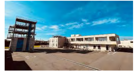
消防署・訓練施設（奈良県広域消防組合）
