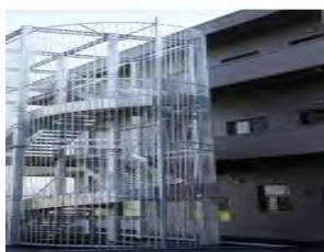
避難階段の設置
