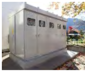
電源設備嵩上げ
