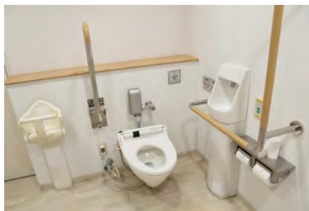
多機能トイレの整備
