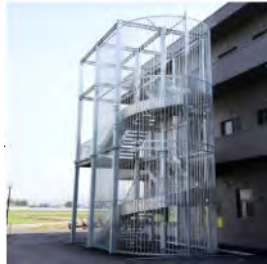
避難階段の設置
