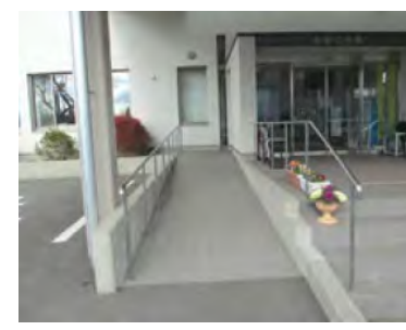
出入口の段差解消
