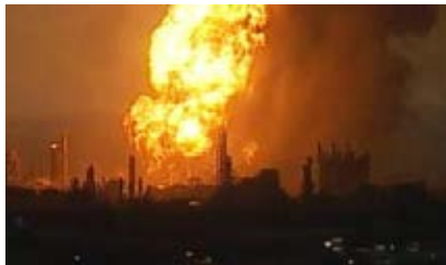
東日本大震災における石油コンビナート火災（市原市消防局提供）
