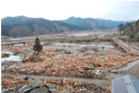
写真2.2-3 津波により浸水した岩手県陸前高田市 1)
