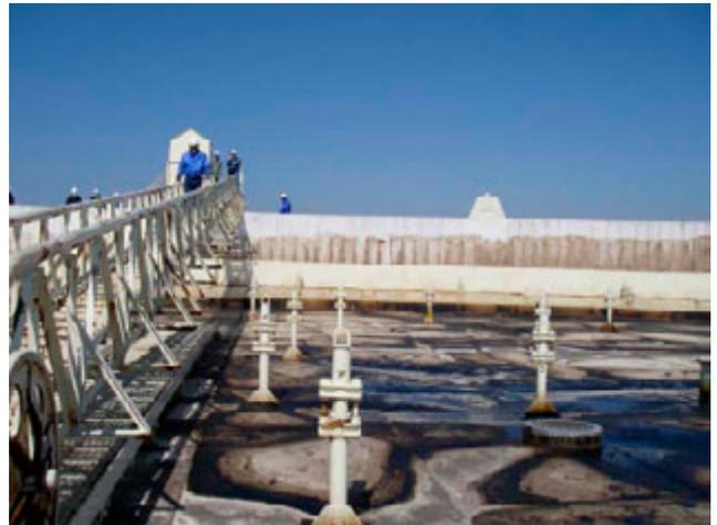
写真 2.3-3 浮き屋根のデッキ上への溢流(新潟県新潟市)<sup>2)</sup>
