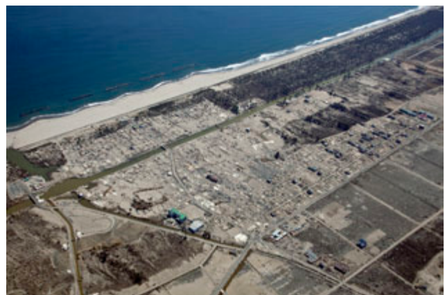
写真3.2-2 仙台市若林区荒浜の津波襲来後の状況 2) (平成23年4月17日撮影)
