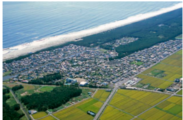
写真3.2-1 仙台市若林区荒浜の津波襲来前の状況 2) (平成15年9月23日撮影)
