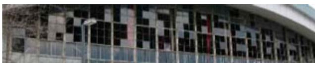
写真3.3-4 ガラス窓の破損(茨城県)<sup>1)</sup>
