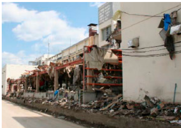
写真3.3-70 陸前高田市庁舎の裏側 1)
