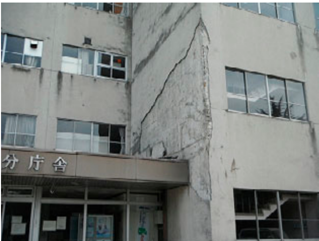
写真3.3-77 福島県庁東分庁舎の1階の外壁 1)
