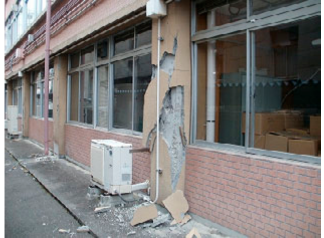
写真3.3-78 郡山合同庁舎の外壁 1)
