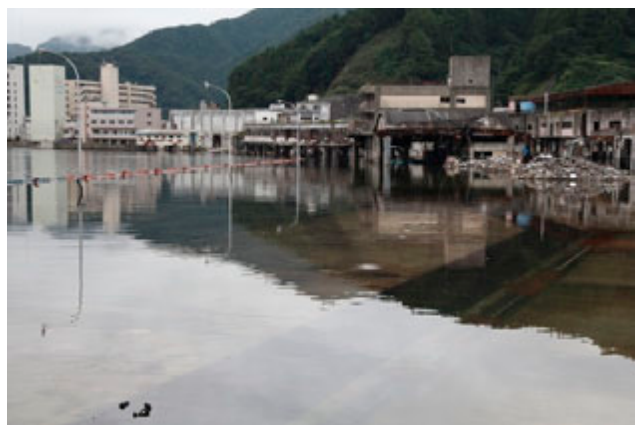
写真3.3-59 埠頭が沈下した岩手県釜石港 1)
