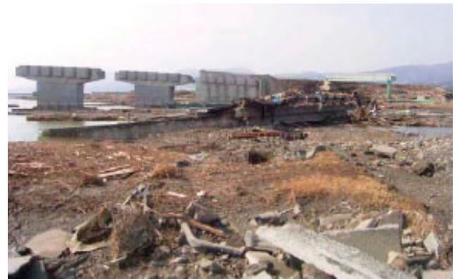
写真3.3-64 津波による橋の流出被害の様子 3)
