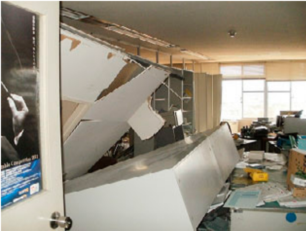
写真3.3-76 福島県庁西庁舎の12階内部 1)
