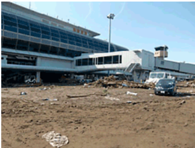
写真3.3-62 被害を受けた仙台空港（宮城県） 2)
