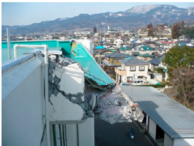
写真3.3-81 国見町役場庁舎屋上階の防水立上り部分 1)
