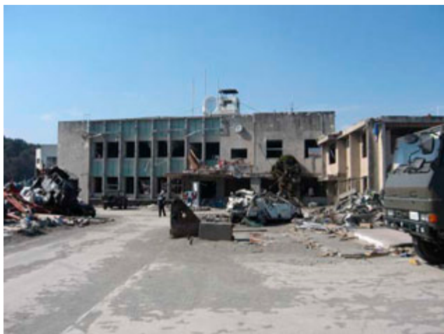
写真3.3-68 大槌町役場の全景 1)
