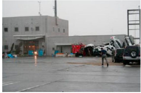
写真3.5-9 津波で被災した荒浜航空分署の全景 2)
