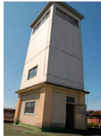
写真3.5-30 被災した東分署の望楼 1)
