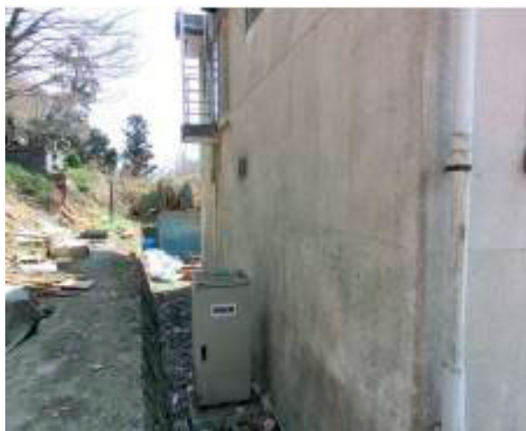
写真3.5-17 津波により使用不能となった湊出張所の発電機 1)
