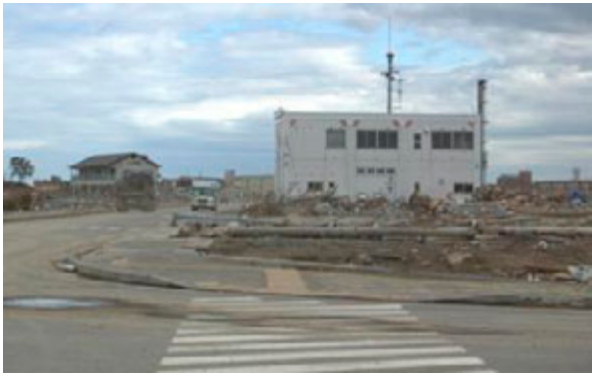
写真3.5-11 周囲の建物が消失した関上出張所の庁舎 1)
