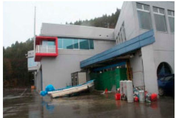
写真3.5-5 山田消防署の正面入口 (船は漂流してきたと推定される) 1)
