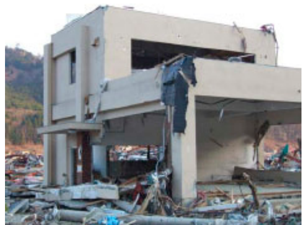
写真3.5-22 雄勝出張所の庁舎の正面入口及び車庫 1)
