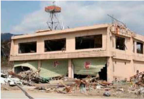
写真3.5-3 陸前高田消防署正面の状況 1)
