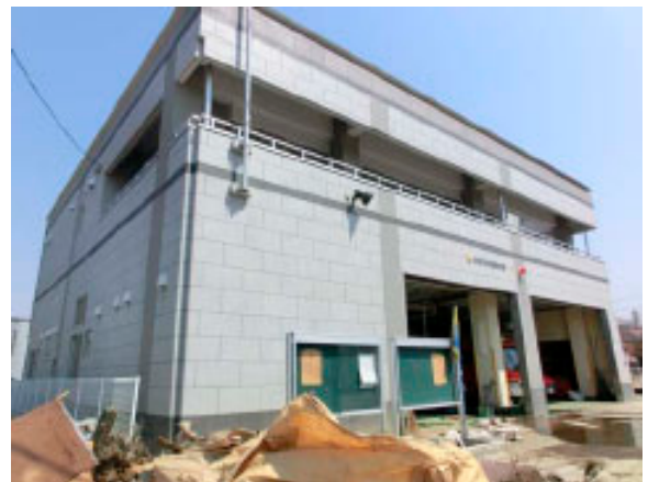
写真3.5-16 周囲にがれきがある南分署の庁舎前 1)
