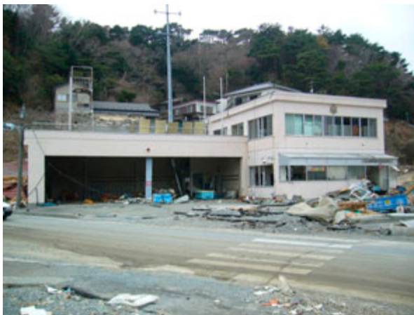
写真3.5-23 津波で被害を受けた牡鹿出張所 1)
