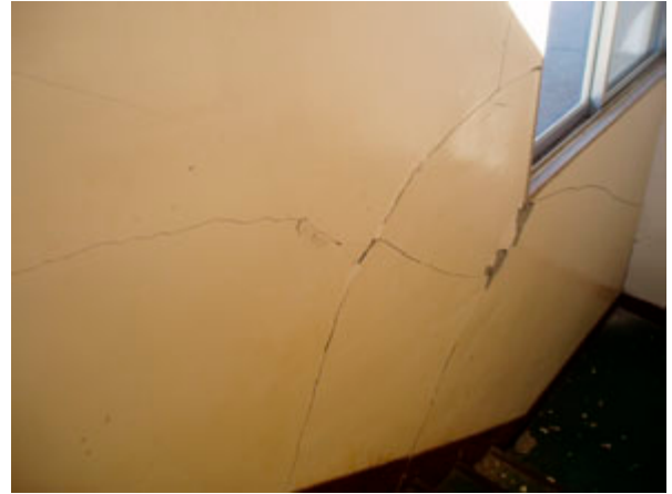
写真3.5-48 石川消防署古殿分署の内部 1)
