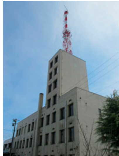
写真3.5-44 発災直後の須賀川地方広域消防本部 1)
