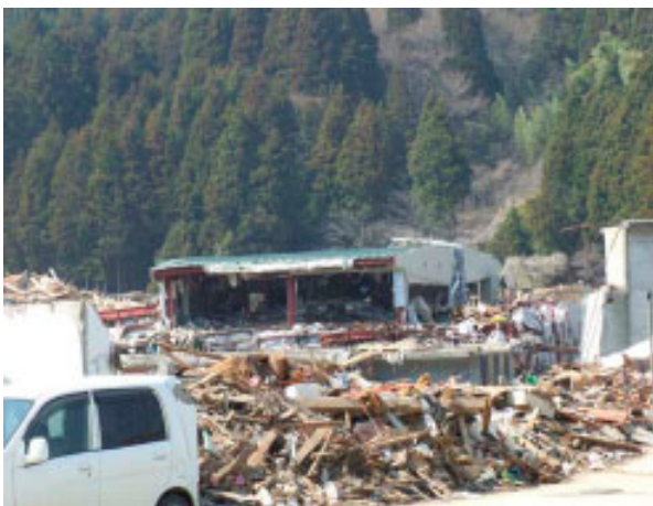
写真3.5-15 壊滅した歌津出張所の庁舎の全景 1)
