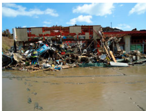
写真3.5-2 津波で全壊した三陸分署綾里分遣所の状況 3)
