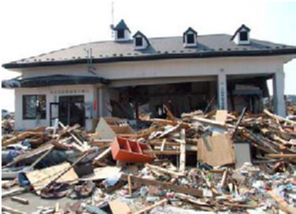
写真3.5-20 鳴瀬出張所の庁舎の正面と前面道路 1)
