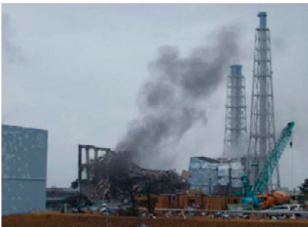
写真3.7-1 東京電力福島第一原発3号機（平成23年3月21日撮影、東京電力（株）提供）
