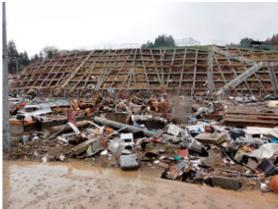
本吉町大沢漁港の被害状況
