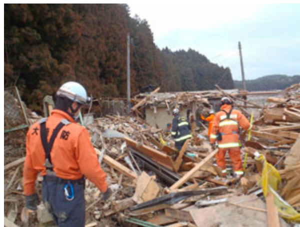
写真4.5-3 3月15日、宮城県南三陸町志津川地区で検索活動を行う大崎地域広域行政事務組合消防本部隊員 1)
