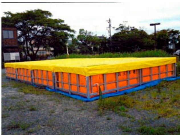
写真 5.3-2 双葉町役場駐車場に設置の防火水槽<sup>2)</sup>
