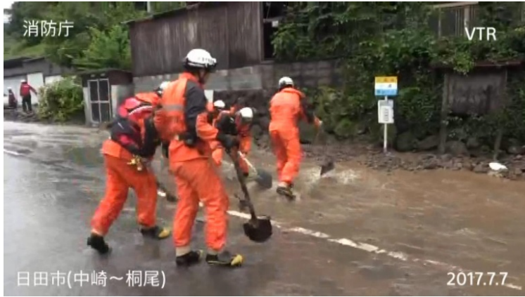
排水・障害物除去作業の様子 【日田市中崎】 (撮影 消防庁)
