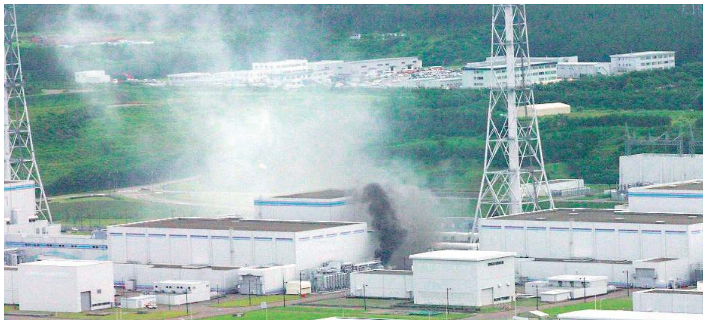
平成 19 年 黒煙を上げる柏崎刈羽原子力発電所 3 号機所内変圧器 2007 Transformer within Unit 3 at the Kashiwazaki-Kariwa nuclear power plant emitting black smoke
