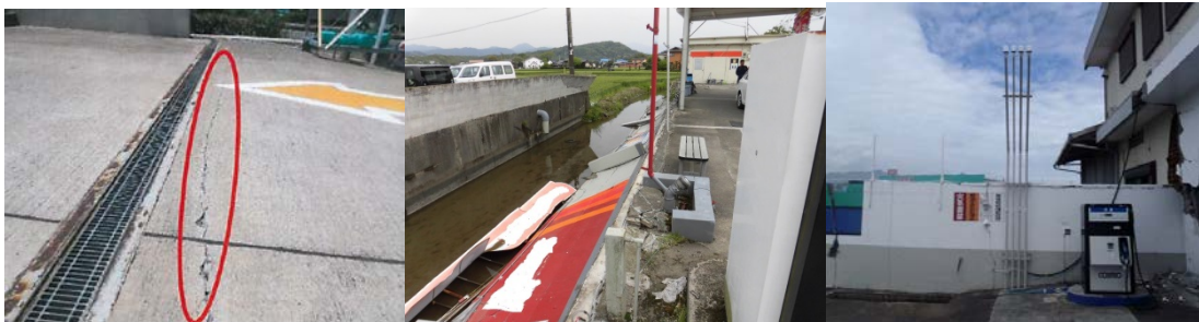
写真9 給油取扱所での被害状況
