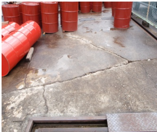
写真 8 屋外貯蔵所における被害状況
