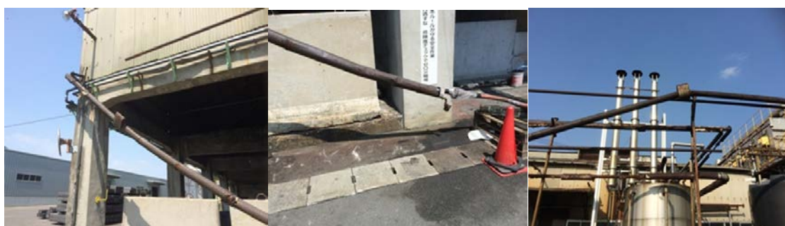
写真2 一般取扱所での流出現場
