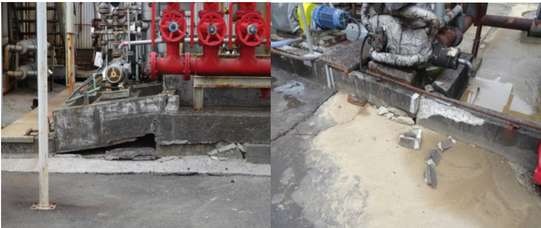
写真4 製造所における被害状況
