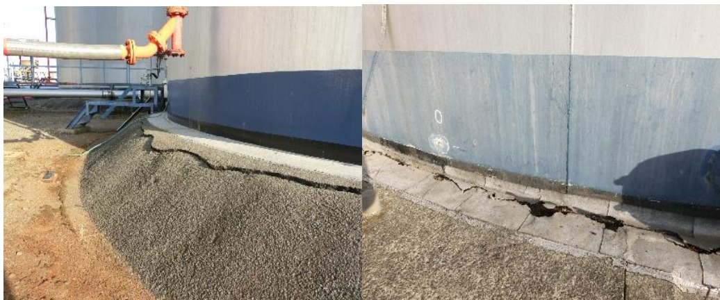
写真 6 屋外タンク貯蔵所における被害状況
