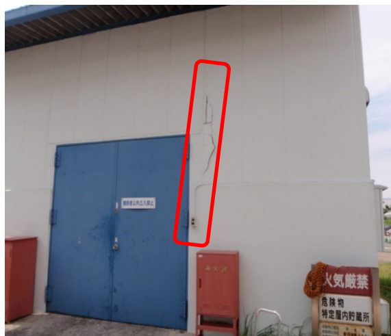
写真5 屋内貯蔵所の被害状況
