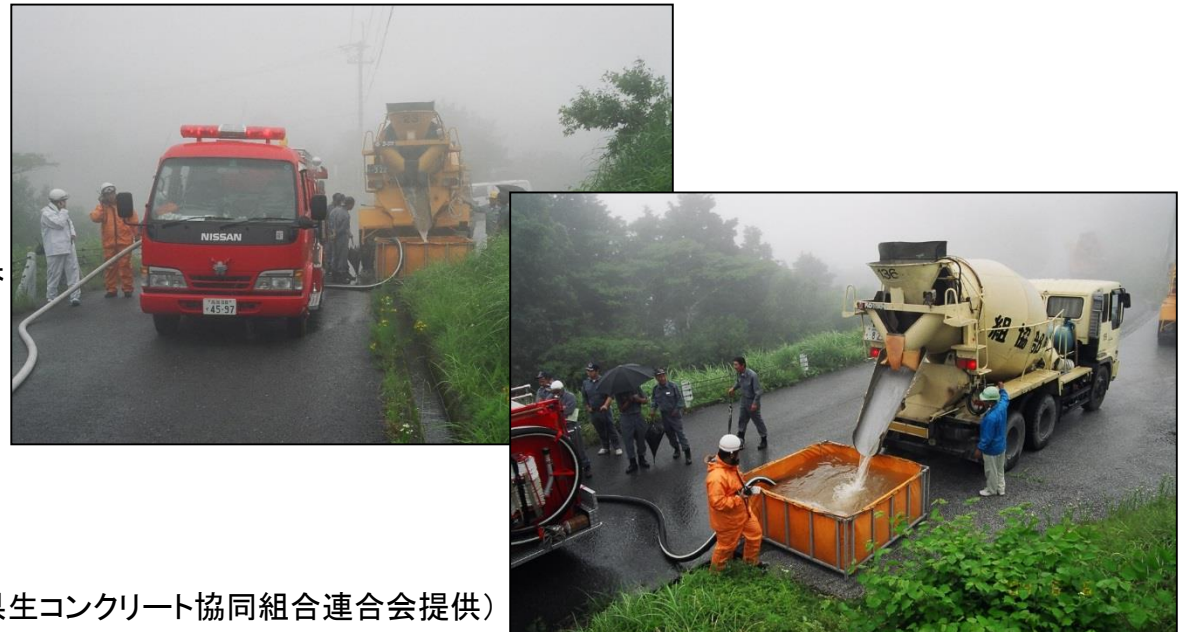
【コンクリートミキサー車を活用した仮設防火水槽への給水訓練】
