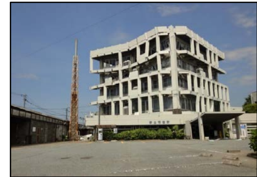
熊本地震で被災した宇土市庁舎
