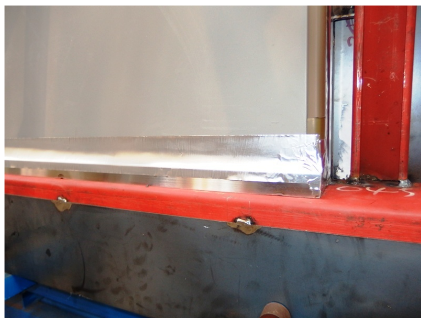
下枠と戸の間にアルミテープ処理
