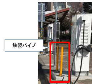
付加的に鉄製パイプを設けた事例
