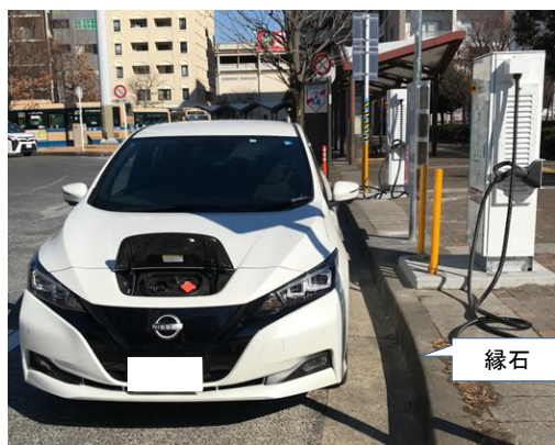
車道と急速充電設備との間に縁石を設けている事例
