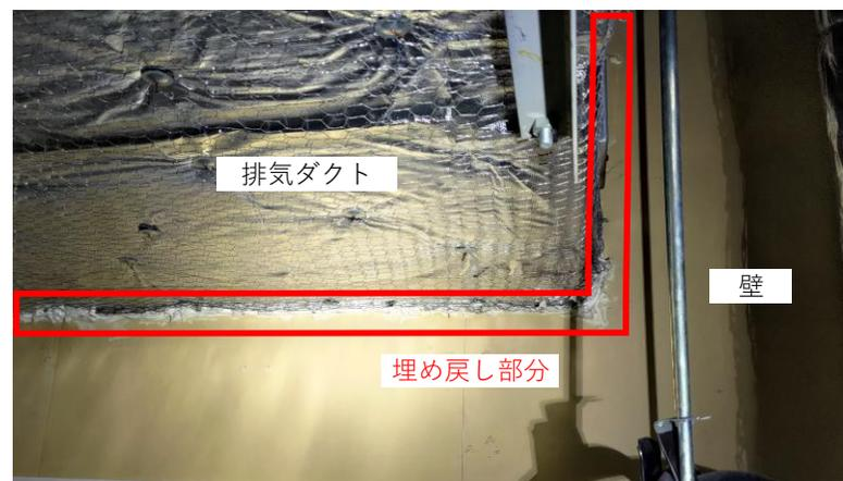
給排気ダクトの区画貫通部分が不燃材料（耐火パテ、モルタル等）で適切に埋め戻しされ、間隙がないことを確認する。
