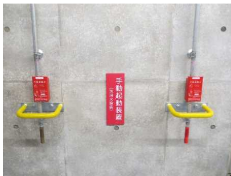
手動起動装置に保護ガードを設置
