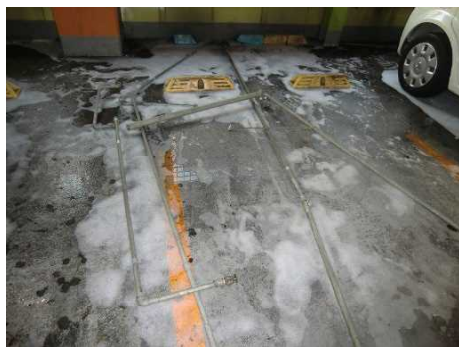
泡流出事故の例
